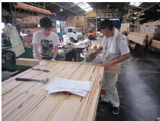
学生による Brett Schuttel の パネル試作 (CN釘により積層)
