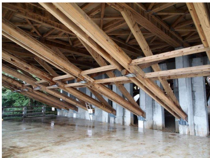
大舞台を支えるスギ平角による方杖構造
